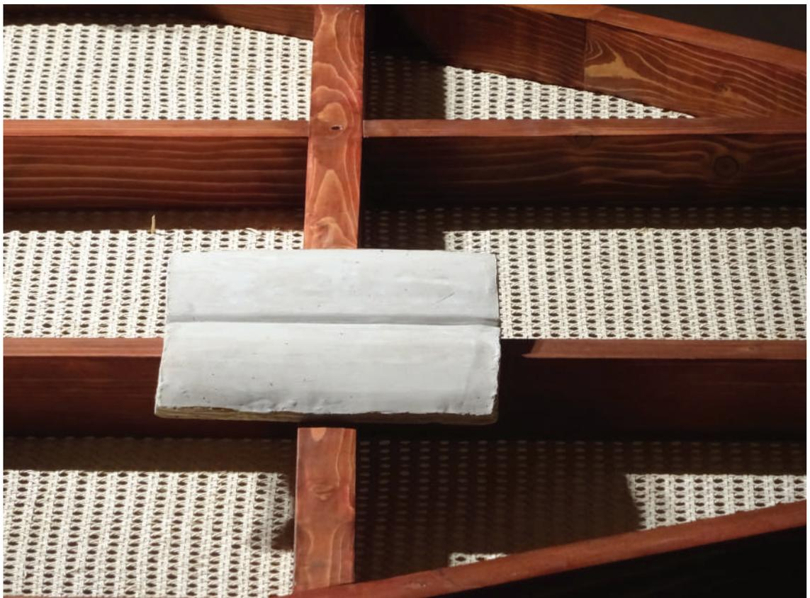
Detalle del carnet en arcilla blanca sobre esta estructura suspendida, inaccesible
